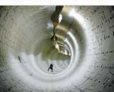
Damit Beton keine Risse bekommt, muss er richtig gemischt sein. Foto: jdp
