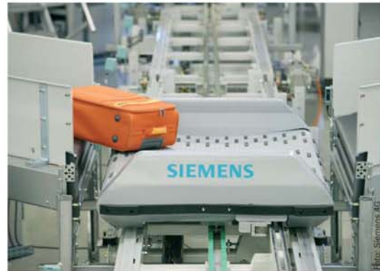
Die Gepäckförderanlage erstreckt sich über 8500 Quadratmeter
